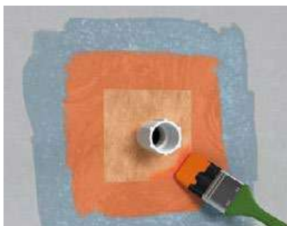
Fig. 4 + 5: Pentru etanșarea trecerilor de țevi, încorporați manșonul de etanșare a peretelui fermacell™ în folia lichidă fermacell™ încă umedă și vopsiți din nou direct - timp de uscare cel puțin 1 oră
