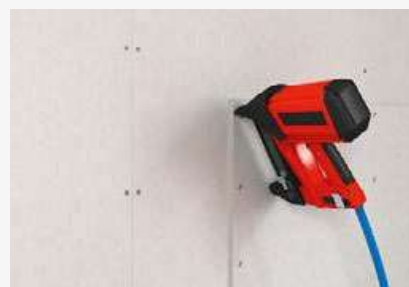
Capsarea plăcilor din ipsos armat fermacell® cu plăcile din ipsos armat fermacell® (neutru față de substructură)
