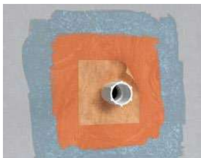
Fig. 4 + 5: Pentru etanșarea trecerilor de țevi, încorporați manșonul de etanșare a peretelui fermacell™ în folia lichidă fermacell™ încă umedă și vopsiți din nou direct - timp de uscare cel puțin 1 oră
