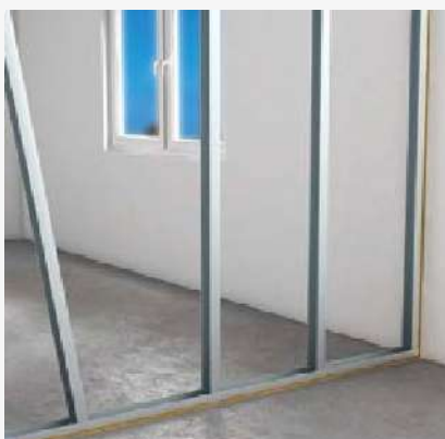
Montarea profilelor verticale CW
