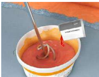
Fig. 8: A doua aplicare: Adăugați concentratul de culoare la cantitatea rămasă de folie lichidă și amestecați omogen. Aplicați cu generozitate folia lichidă colorată. Informații suplimentare pot fi găsite în fișa tehnică a produsului. Este recomandabil să aplicați al doilea strat în unghi drept față de primul pentru a evita imperfecțiunile stratului de impermeabilizare.
