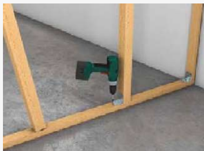
Montarea stâlpilor de lemn cu cuie sau suporturi de oțel
