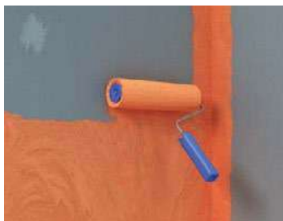
Fig. 7: Asigurarea impermeabilizării pentru clasa de expunere la apă W1-I și W2-I. Aplicați fermacell™ film lichid cu o rolă pe întreaga suprafață de cel puțin două ori (grosimea stratului uscat de cel puțin 0,5 mm). În conformitate cu DIN 18534-3, este necesară o diferență de culoare pentru a doua aplicare pentru o mai bună trasabilitate. Prima aplicare: Aplicați folia lichidă fermacell™ în culoarea originală și lăsați să se usuce
