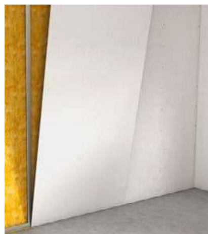
termoizolante Placarea substructurii metalice
