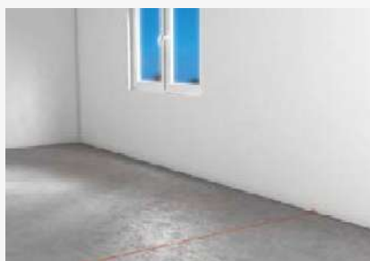
Poziționarea axei peretelui cu o linie de coardă sau cu un laser de construcție înaltă
