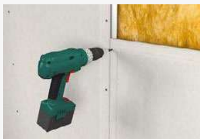
Șuruburi pe substructura de oțel
