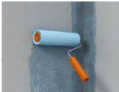
Fig. 1: Aplicarea pe toată suprafața a fermacell™ Deep Primer - timp de uscare de cel puțin 2 ore - raport de amestecare: 1:1 până la 1:2 cu apă
