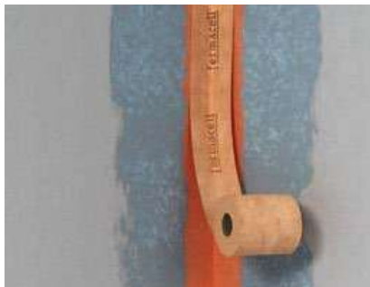
Fig. 2 + 3: Apăsăți banda de etanșare fermacell™ în folia lichidă fermacell™ aplicată anterior, încă umedă și acoperiți direct cu folie lichidă - timp de uscare cel puțin 1 oră
