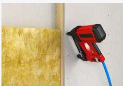
Capse pe substructura de lemn
